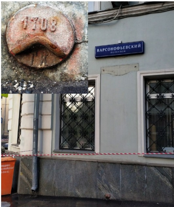
Рис. 2. Нивелирный репер ГК, установленный в цоколе здания на углу Варсонофьевского переулка и ул. Рождественка. Фото автора, февраль 2019 года
