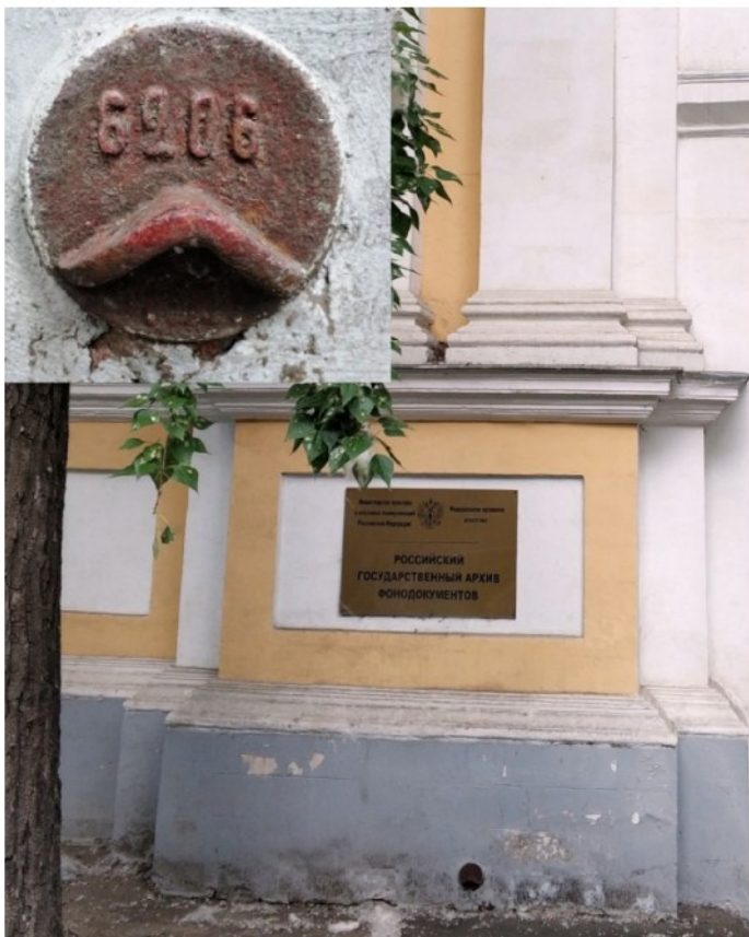
Рис. 5. Нивелирный репер ГК, установленный в цоколе бывшего Лефортовского дворца. Фото автора, июнь 2019 года
