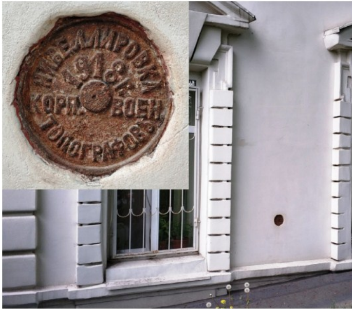
Рис. 8. Нивелирная марка КВТ 1918 года, установленная в стене здания станции МОЖД Канатчиково. Фото автора, май 2019 года
