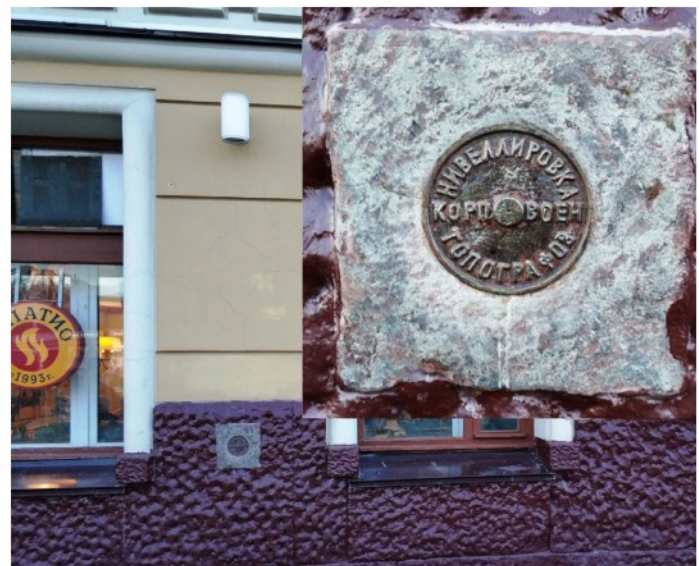
Рис. 10. Нивелирная марка КВТ 1923 года, установленная в цоколе здания Ярославского вокзала. Фото автора, май 2019 года
