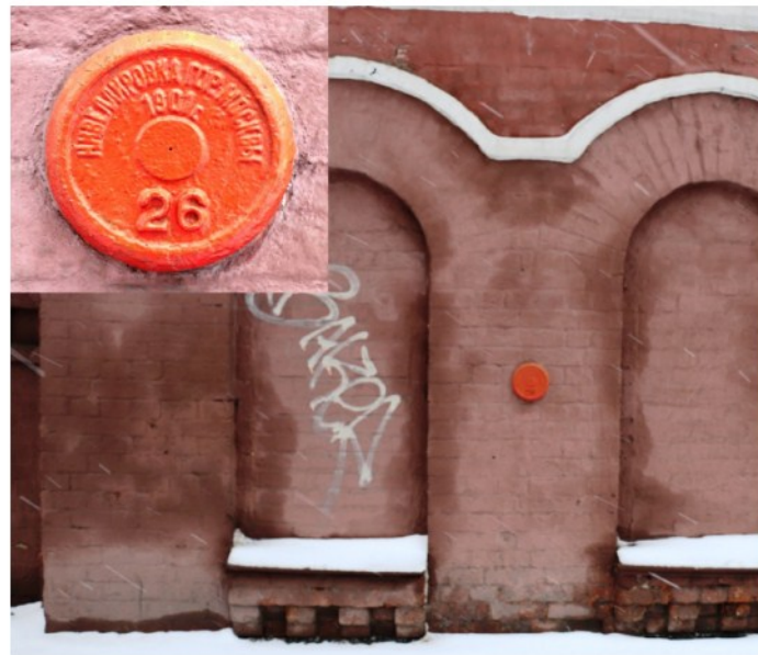
Рис. 7. Нивелирная марка 1901 года, установленная в стене шахты бывших городских боен. Фото автора, январь 2019 года
